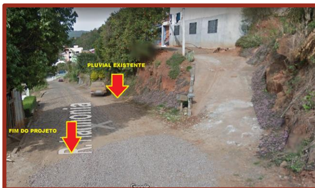
Figura 9 – Deságue em caixa existente
