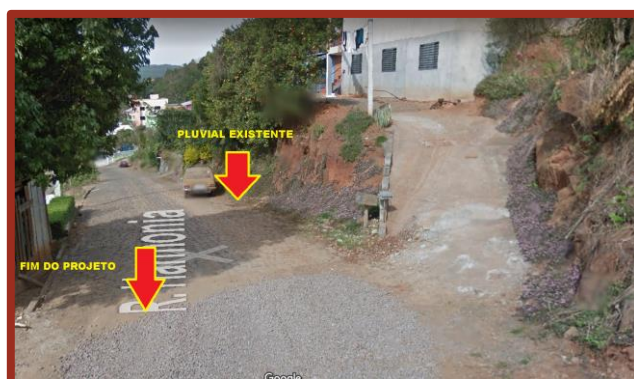
Figura 9 – Deságue em caixa existente
