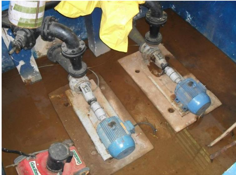
**Foto 10 – Conjunto Moto-bomba, Recalque ETA**
